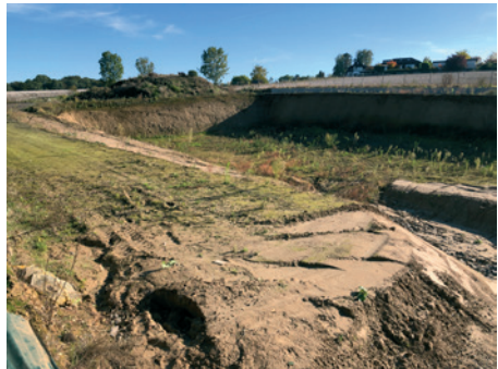
Die Baustelle ruht seit Monaten
