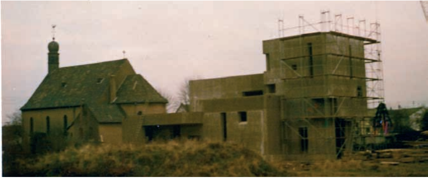
Alte Kirche und die im Rohbau befindliche neue Kirche. (Dieses Foto wurde aus Sicht der Weinheimstraße aufgenommen.)
